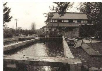
調理場を建てる直前の写真。
